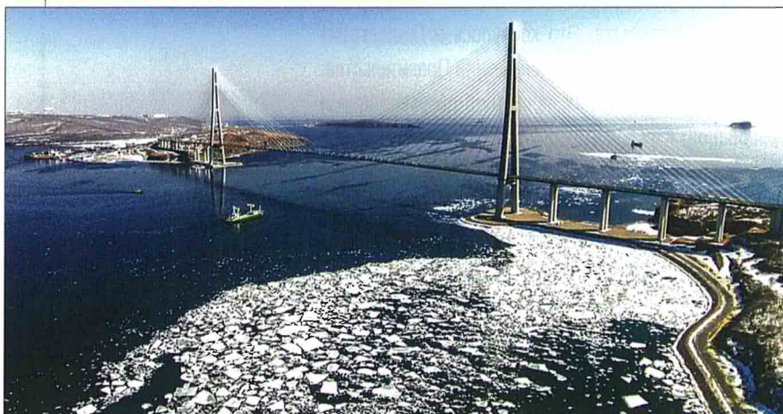
Мостовой переход на о. Русский через пролив Босфор Восточный
